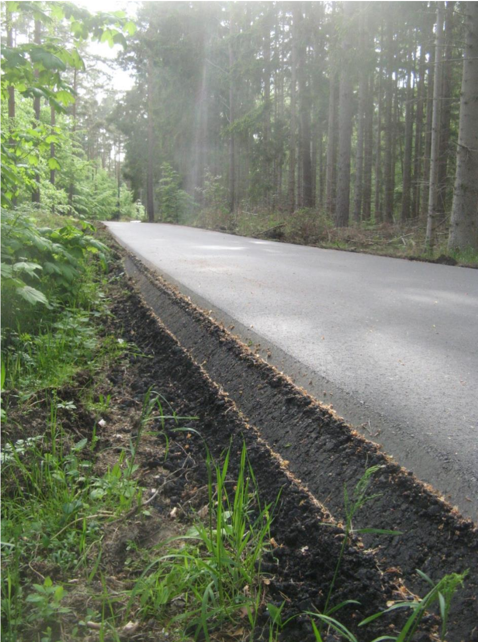
Neue Fahrbahndecke der „Heide-Straße“ (Foto: NABU RV MM e.V.)
